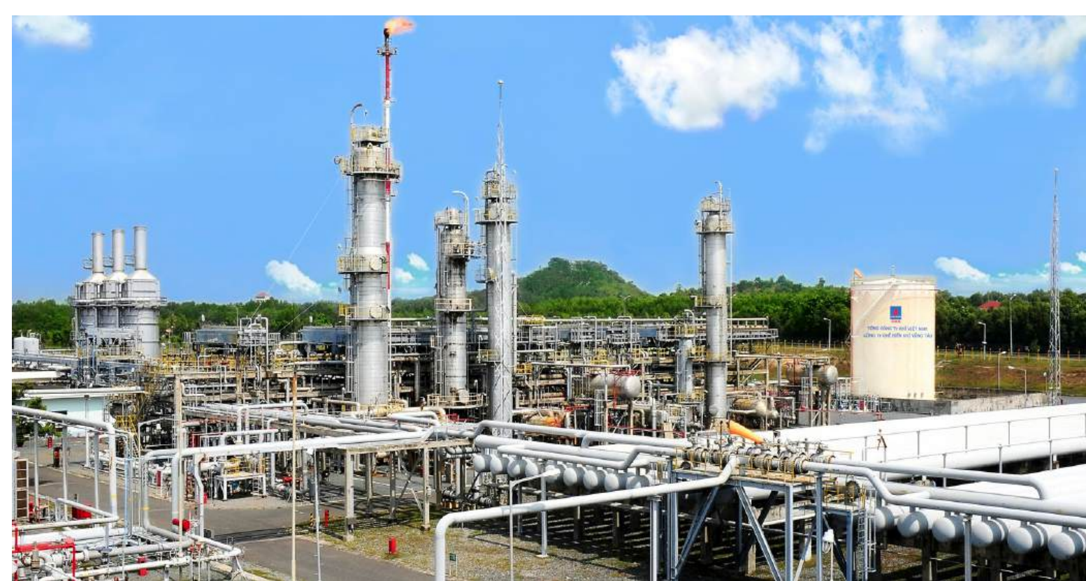
NHÀ MÁY XỬ LÝ KHÍ DINH CỐ DINHCO GAS PROCESSING PLANT
