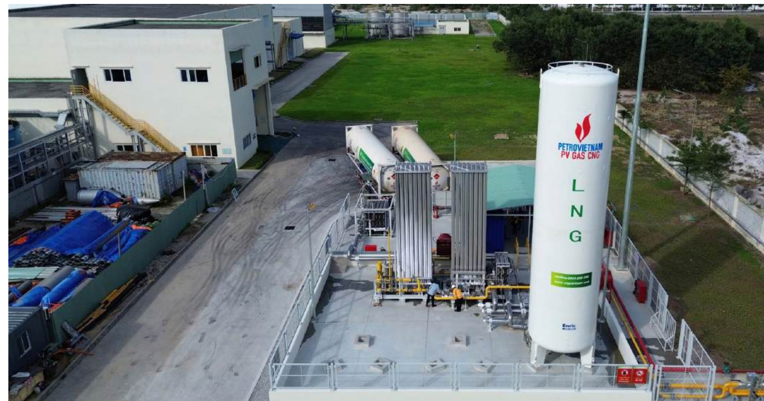
NHÀ MÁY HYOSUNG QUẢNG NAM HYOSUNG QUANG NAM FACTORY
